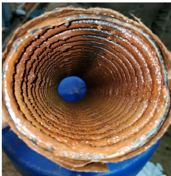
Труба 109 – до промывки
