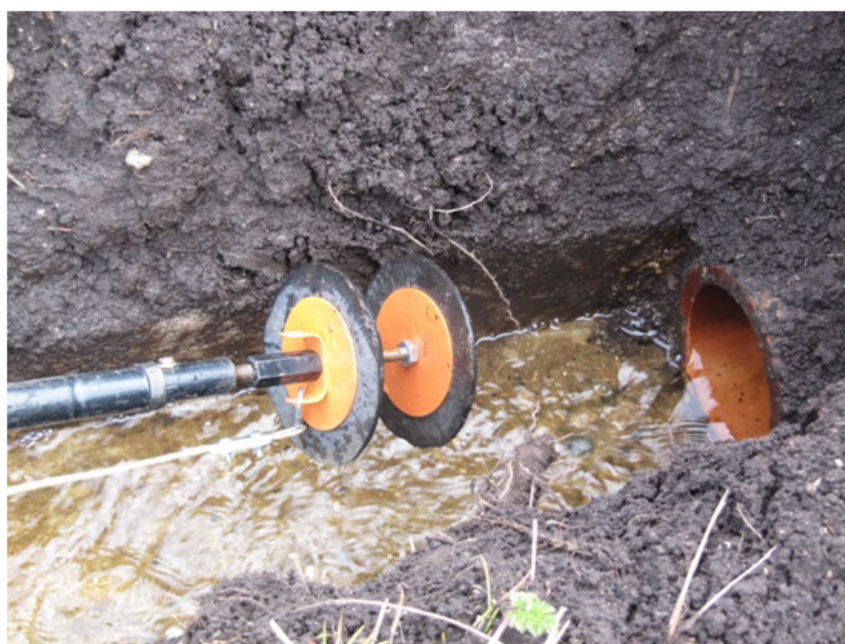
Рис. 5. Герметизатор на установочной штанге
