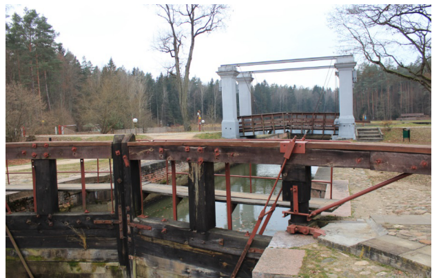
Рис. 2. Шлюз «Домбровка» на Августовском канале
