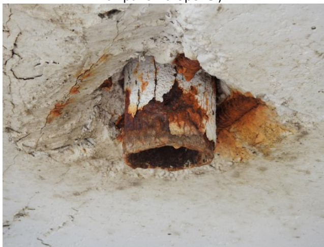
Рис. 5. Скол бетона в плите П8 пролета № 2 в зоне водоотводной трубки. Коррозия водоотводной трубки
