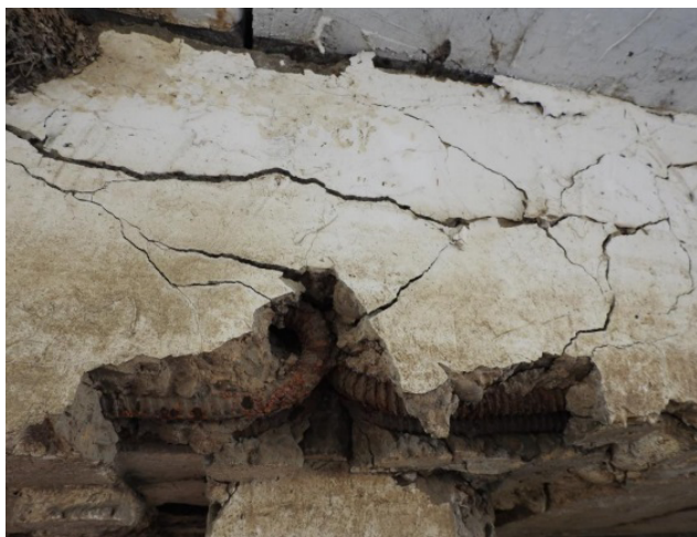
Рис. 6. Разрушение стыка омоноличивания блоков насадки опоры № 2 над сваей № 3
