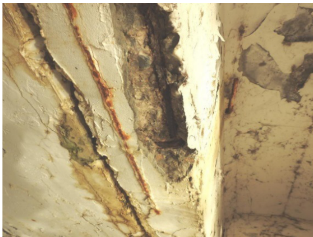
Рис. 3. Разрушение защитного слоя бетона в пролете № 2 (вид от начала моста с правой стороны)
