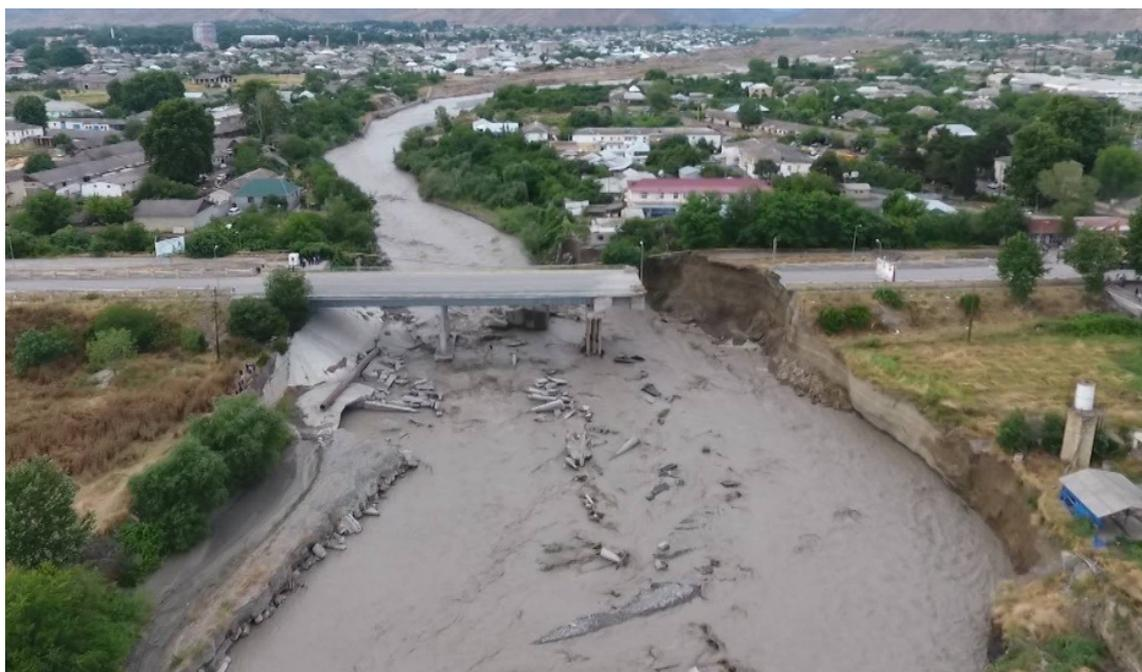
Рис 1. Разрушенный мост на автомагистрали Баку – Шамахи-Евлах, р. Гёкчай, 2018 г.
