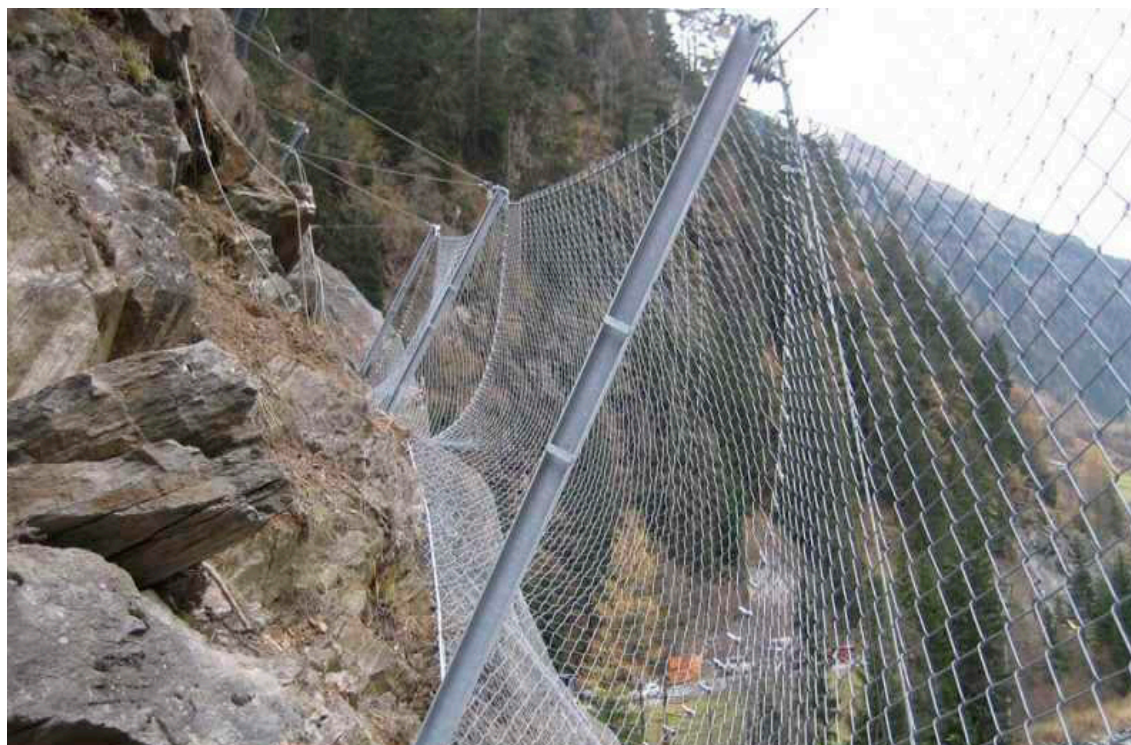
Рис. 5. Смонтированные гибкие улавливающие противообвальные сооружения в гп. Красная Поляна
