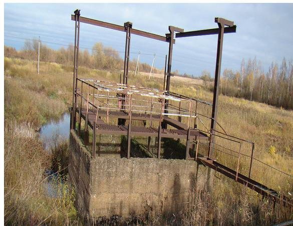
Рис. 3 – Башенный водосброс водохранилища «Меркуловичи»
