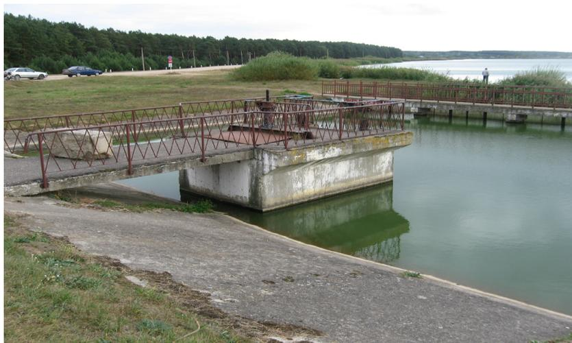
Рис. 4 – Башенный водосброс водохранилища «Зельва»
