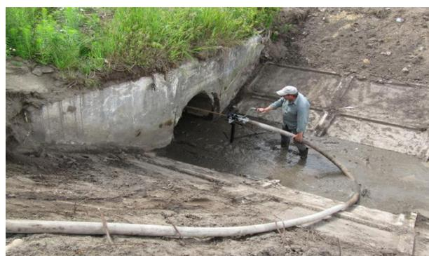
Рисунок 6 – Промывка отложений в полости трубы-переезда при установке гидромонитора ГМ-1 на опоре
