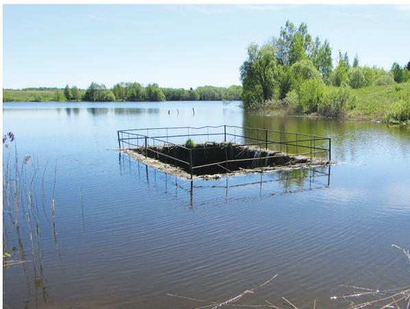
Рис. 2 – Башенный водосброс водохранилища «Стародворское»
