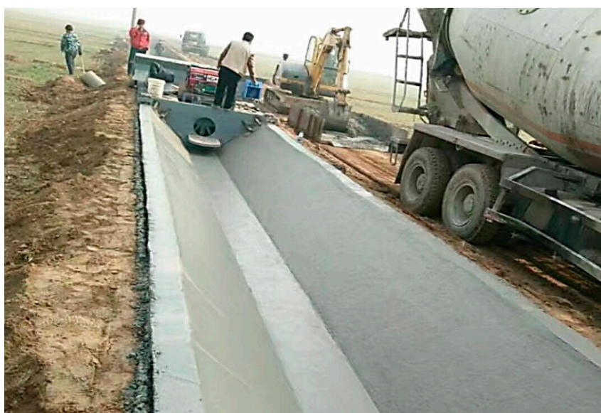
Рис. 2. Бетонная облицовка поперечного сечения канала
