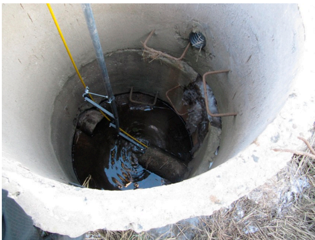
Рис. 4. Штанга направляющая ШН-4 во время очистки коллектора из колодца
