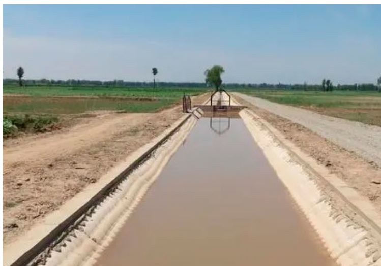
Рис. 3. Бетонная облицовка с применением формовочного мешка
