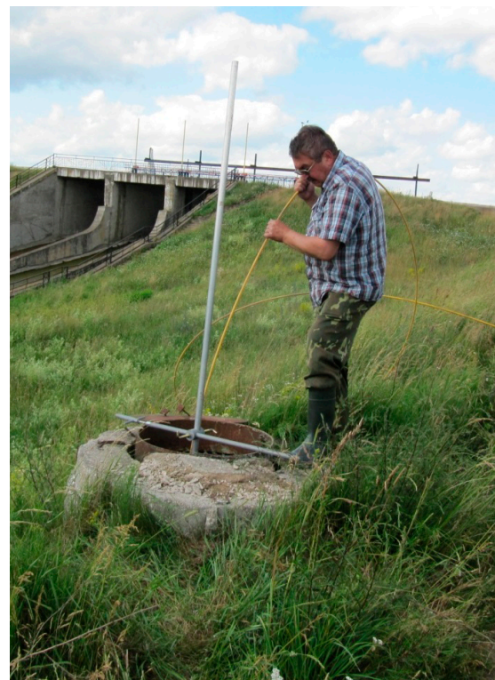
Рис. 2. Очистка коллектора из колодца с помощью штанги направляющей ШН-4
