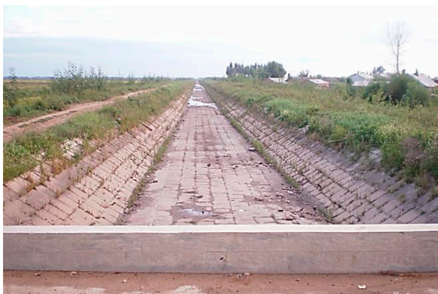
Рис. 1. Облицовка канала сборными железобетонными плитами
