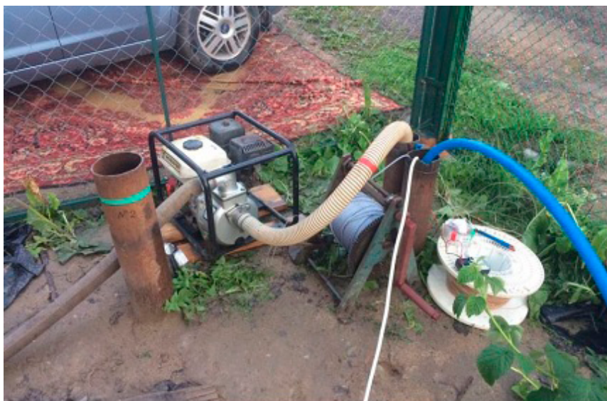
Рис. 3. Полевые испытания скважины двухколонной конструкции
