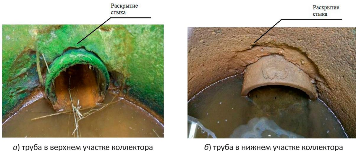
Рис. 4. Заиливание трубопровода большого диаметра АК-1-1 из асбестоцементных труб на мелиоративной системе «Молотковичи» (2023 г.)
