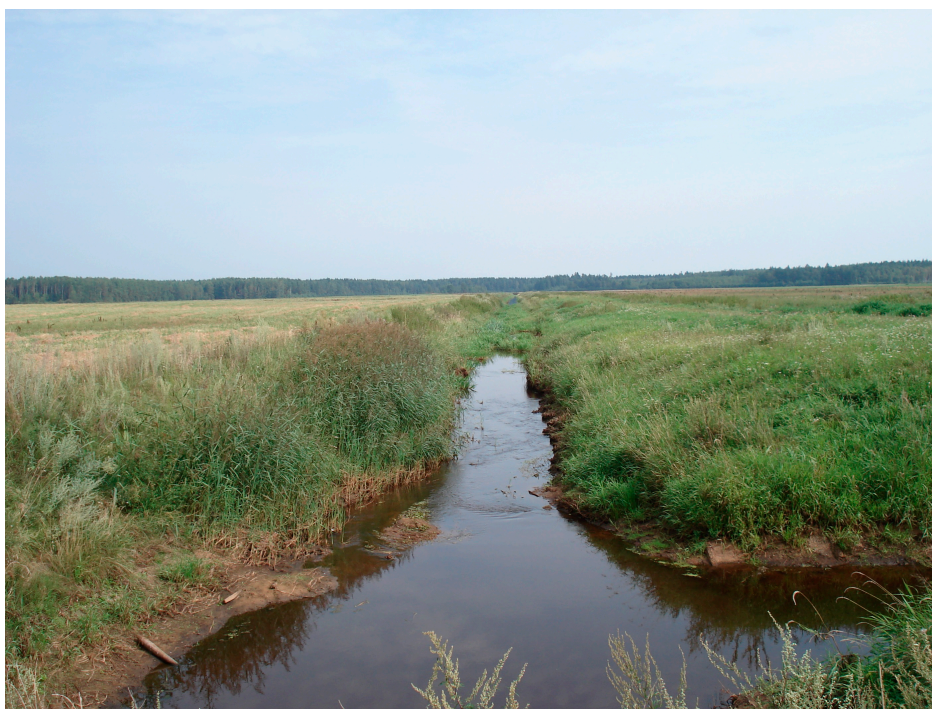
Рисунок. Деформация и обрушение откосов канала магистрального канала мелиоративной системы (Смолевичский р-н Минской обл.)
