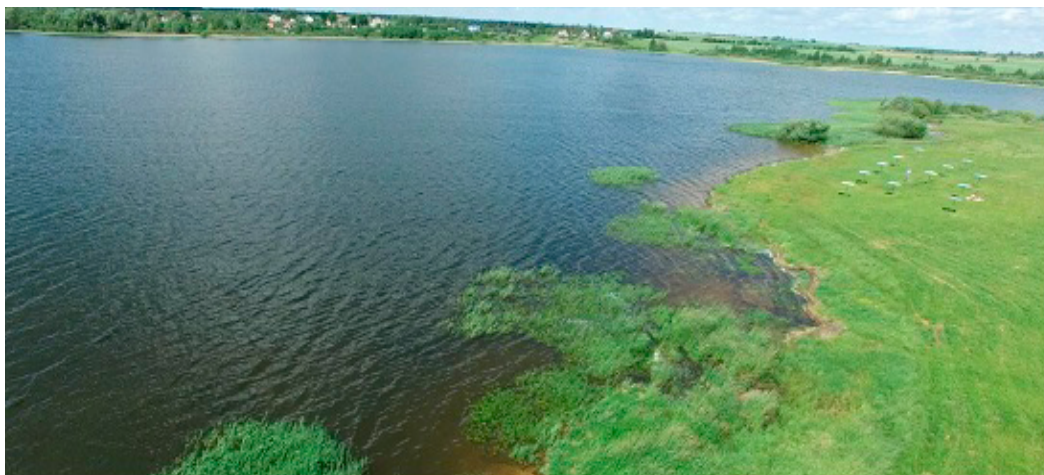
Рис. 6. Подтопление правого берега водохранилища Петровичи
