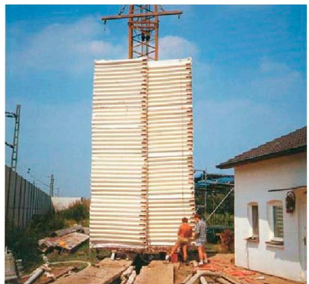
Рис. 1. Устройство виброзащитного и противофильтрационного барьера из газонаполненных баллонов, погружаемых в траншею, выполненную методом «стена в грунте»
