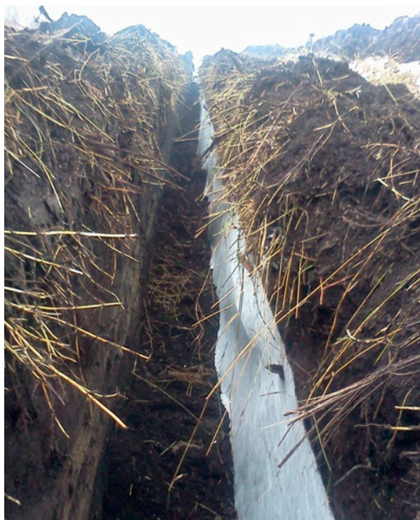
Рис. 14. Фото дрен с пристенным фильтром на объекте «Волма», 2011 г.
