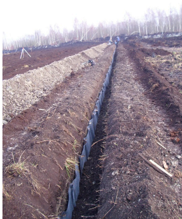
Рис. 14. Фото дрен с пристенным фильтром на объекте «Волма», 2011 г.
