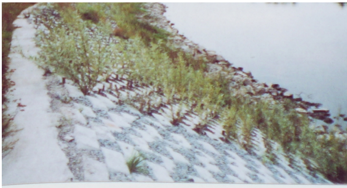
Рис. 2. Гибкое защитное покрытие берега р. Западный Буг, выполненное из бетонных блоков конструкции института «Укроргводстрой»
