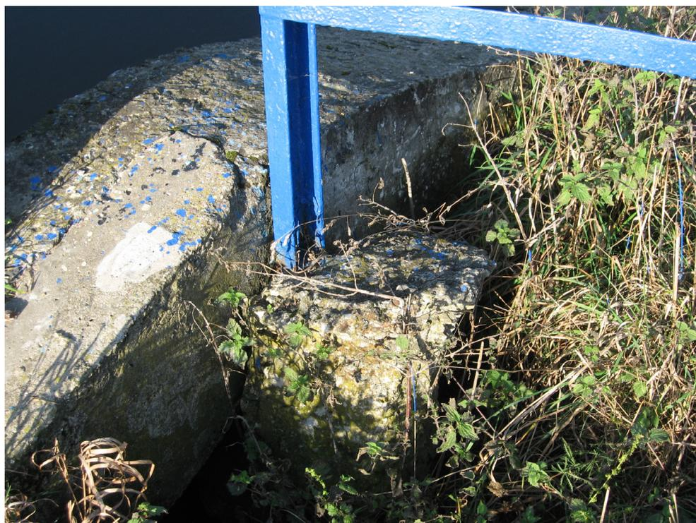
Рис. 5. Провалы грунта в примыкании левобережного устоя
