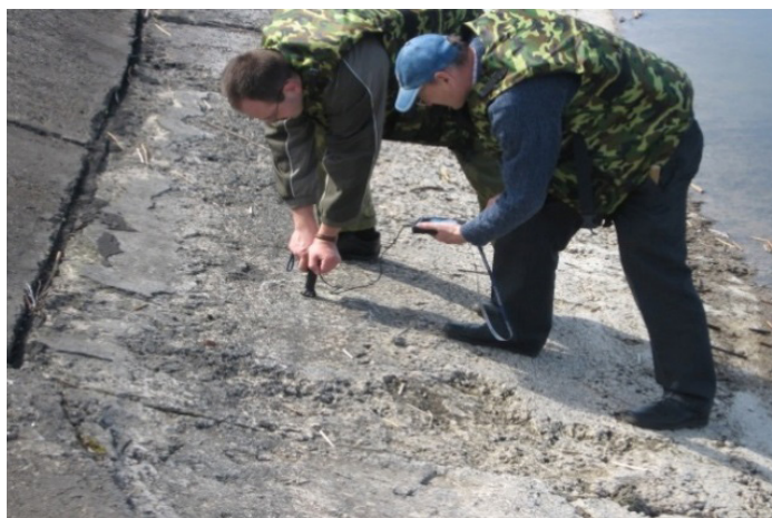
Рис. 7. Определение прочности бетона плит крепления верхового откоса земляной плотины водохранилища «Заславское»
