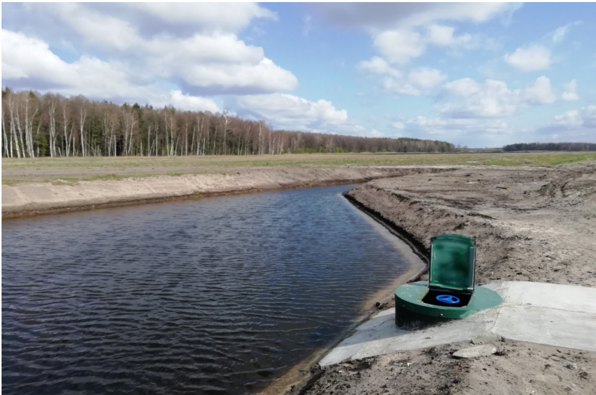
Рис. 11. Фото установленного экспериментального колодца-регулятора на объекте «Нератовка»
