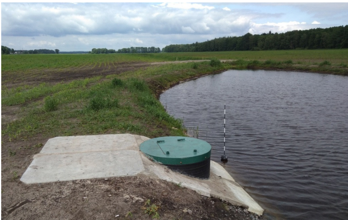
Рис. 12. Фото установленного поплавкового уровнемера на объекте «Нератовка»
