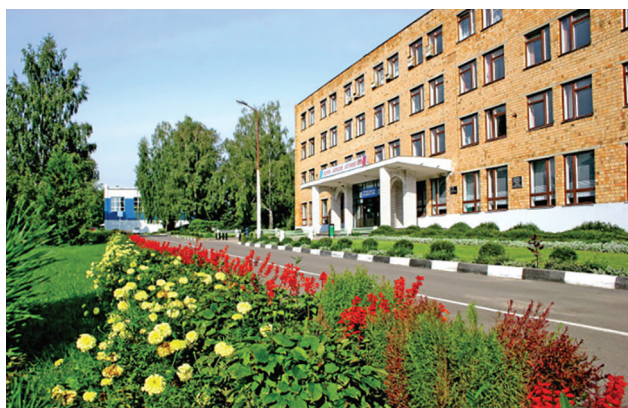
Корпус № 11 мелиоративно-строительного факультета БГСХА
