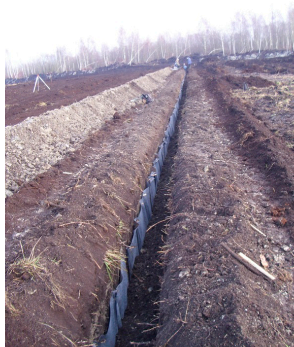
Рис. 14. Фото дрен с пристенным фильтром на объекте «Волма», 2011 г.
