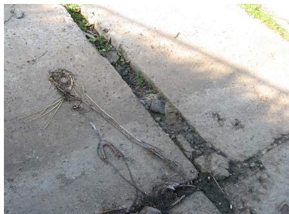
Рис. 2. Напорная грань бычков в зоне переменного уровня и стыки сборных железобетонных плит крепления
