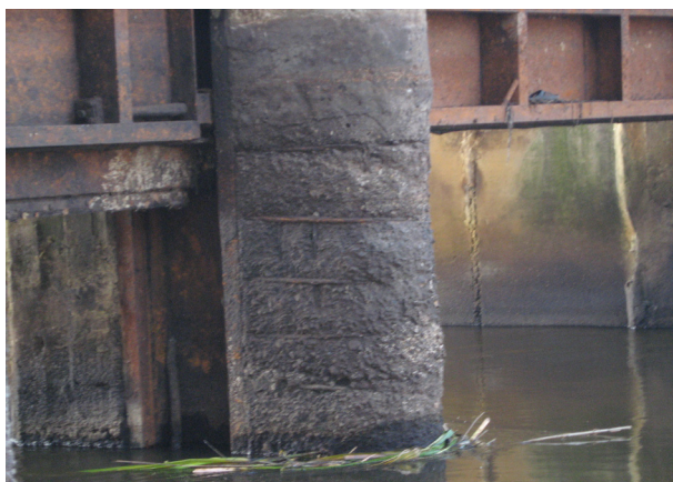
Рис. 2. Напорная грань бычков в зоне переменного уровня и стыки сборных железобетонных плит крепления
