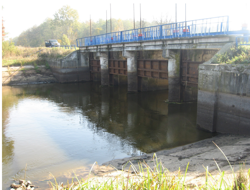
Рис. 1. Общий вид шлюза-регулятора на р. Лань
