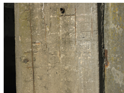
Рис. 3. Каверны, оголение и коррозия арматуры соответственно на боковых поверхностях бычков, плитах перекрытия автомобильного моста и береговом открылке устоя
