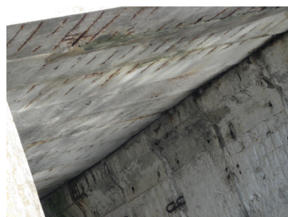
Рис. 3. Каверны, оголение и коррозия арматуры соответственно на боковых поверхностях бычков, плитах перекрытия автомобильного моста и береговом открылке устоя
