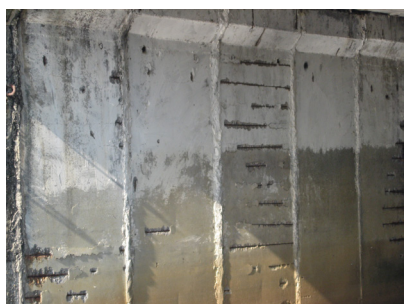
Рис. 3. Каверны, оголение и коррозия арматуры соответственно на боковых поверхностях бычков, плитах перекрытия автомобильного моста и береговом открылке устоя
