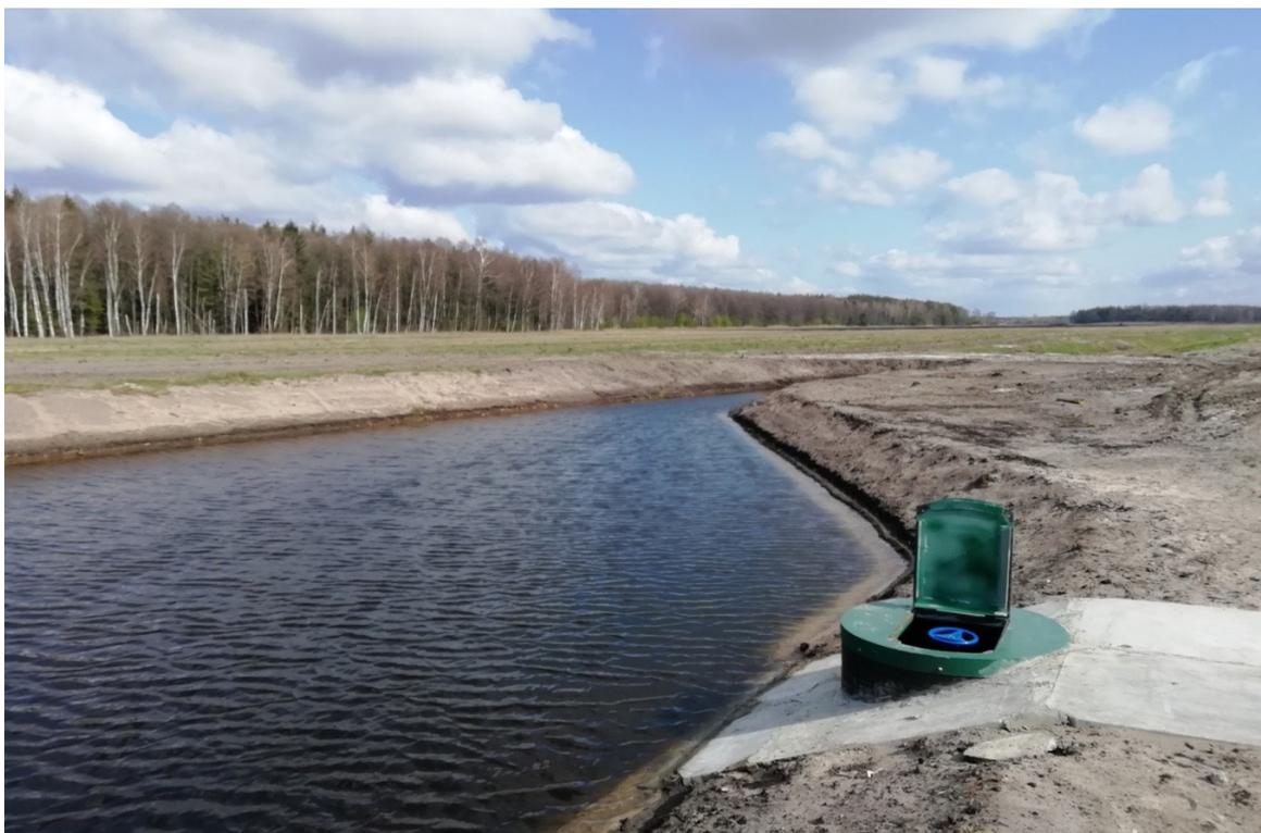
Рис. 11. Фото установленного экспериментального колодца-регулятора на объекте «Нератовка»
