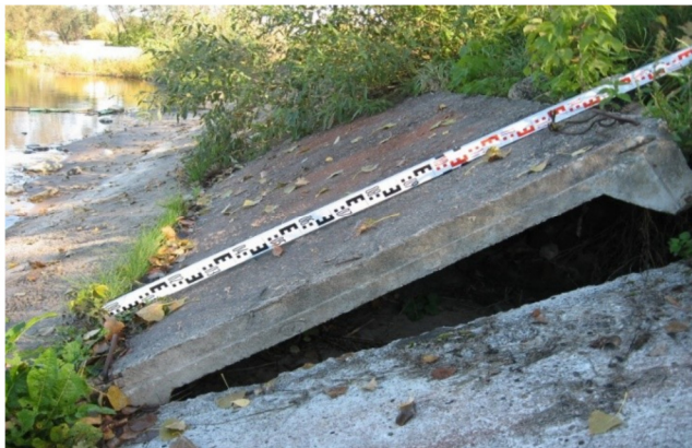
Рисунок 3 – Стадии разрушения крепления откосов:
