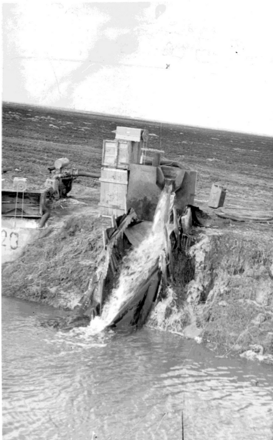
Рисунок 1 – Очистка дренажной системы от заиления откачкой из смотрового колодца в ее устье на объекте «Гоцца-2»
