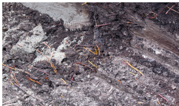
Рисунок 8. – Корни растений, находящиеся в открытой траншее над трассой коллектора
