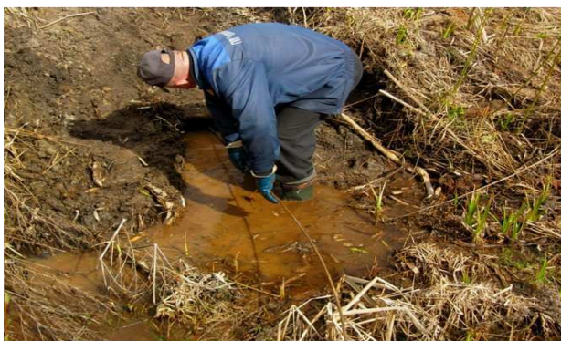
Рисунок 6. – Очистка коллектора от окисных соединений железа (охры) с применением насадки мягкой
