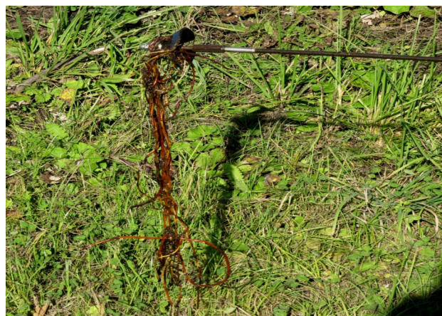
Рисунок 7. – Извлеченные корни растений из коллектора насадкой НМ-80
