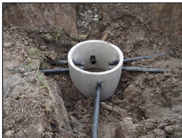
Рисунок 9. – Строительство смотрового дренажного колодца (диаметр – 100 см) для замеров дренажного стока
