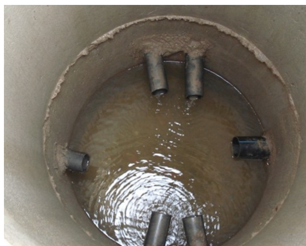
Рисунок 13. – Дренажный колодец для замеров стока из придренных коллекторов на ОПУ «Васюки» (фото 26.03.2014 г.)
