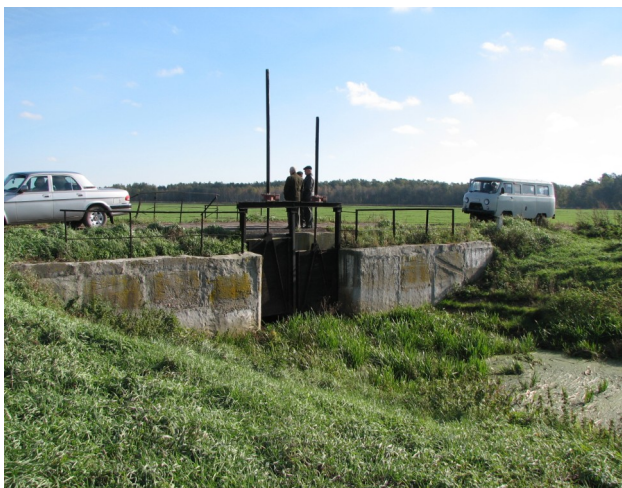
Рисунок 3. – Растительная перемычка перед шлюзом, образовавшаяся на заторе из скошенной травы. Объект «Комарово» Петриковского района Гомельской области
