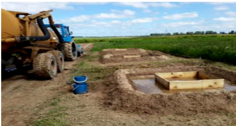
Рисунок 3. – Заливка площадок водой
