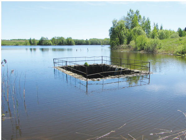
Рис. 2 – Башенный водосброс водохранилища «Стародворское»
