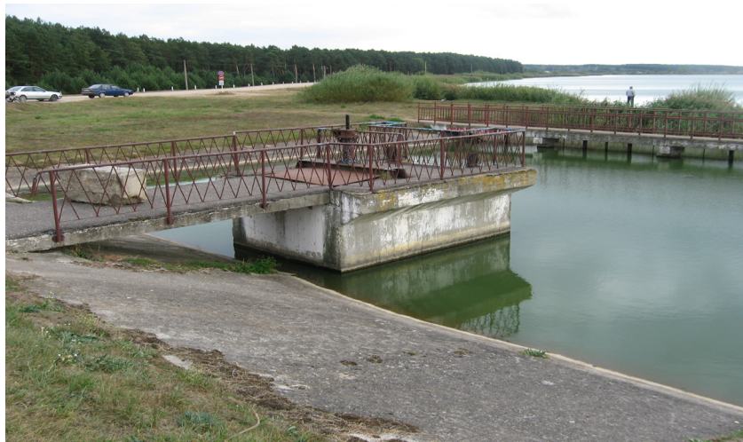
Рис. 4 – Башенный водосброс водохранилища «Зельва»
