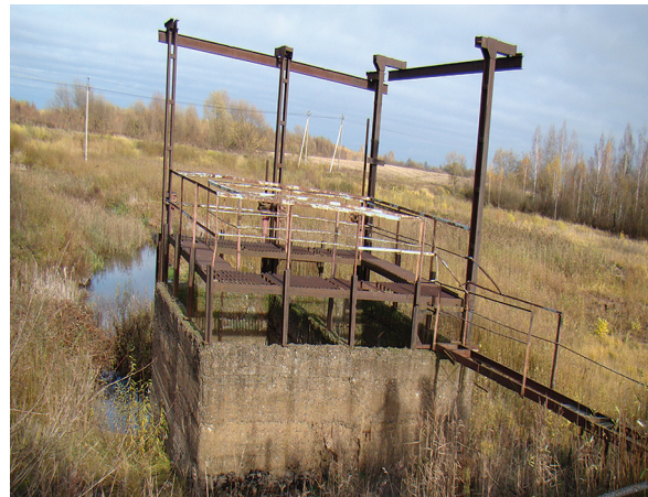
Рис. 3 – Башенный водосброс водохранилища «Меркуловичи»
