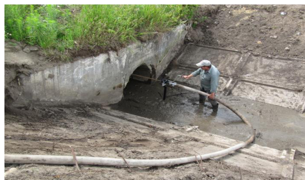
Рисунок 6 – Промывка отложений в полости трубы-переезда при установке гидромонитора ГМ-1 на опоре
