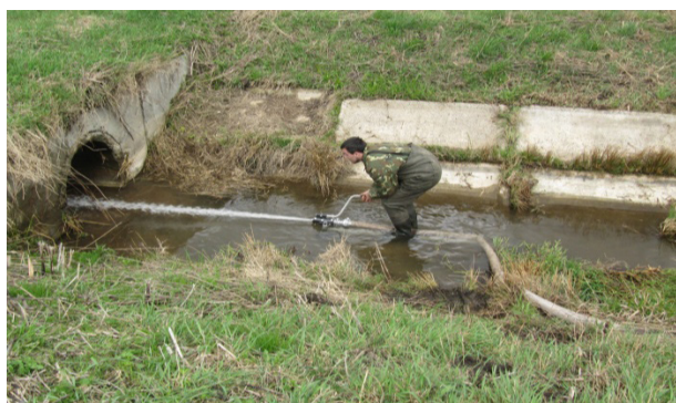
Рисунок 5 – Размыв отложений в полости сооружения с применением гидромонитора ГМ-1 при нижнем уровне расположения ствола
