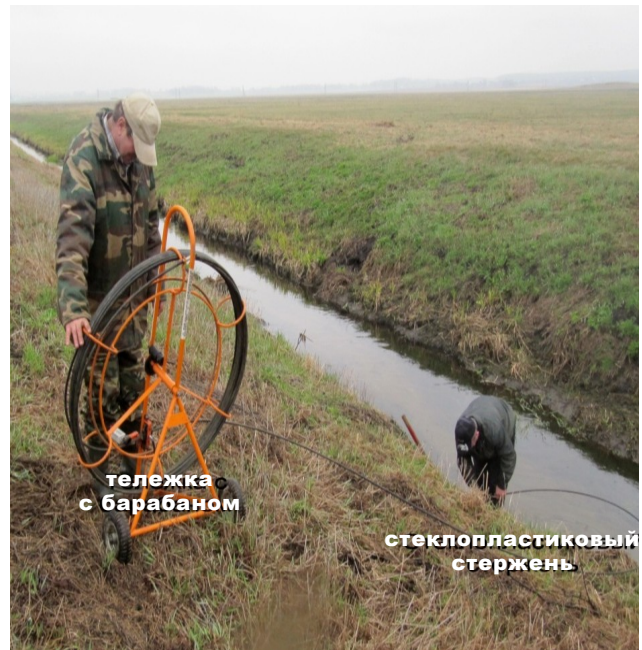
Рисунок 3 – Оценка внутреннего состояния коллектора с применением устройства ОД-100
