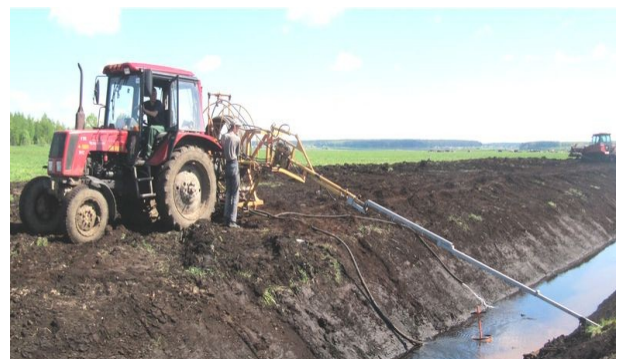
Рисунок 5 – Помывка дренажных коллекторов установкой УПД-120 с применением направляющего устройства УНТ-6 и устройства для забора воды ЗУ-2
