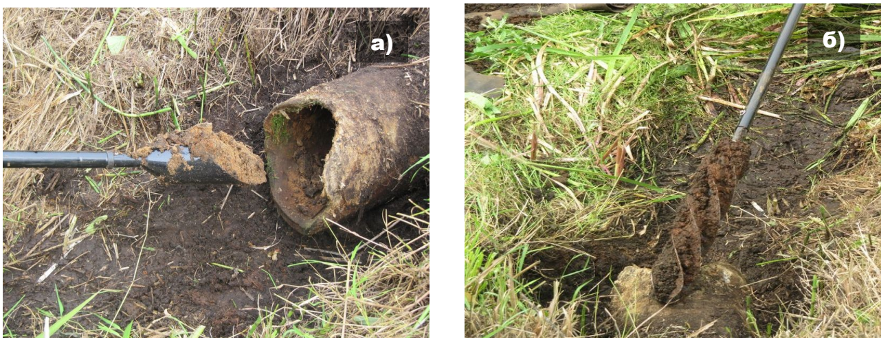
Рисунок 1 – Очистка устьевой части коллектора с применением насадки совковой НС-3(а) и головки винтовой ГВ-1 (б)
