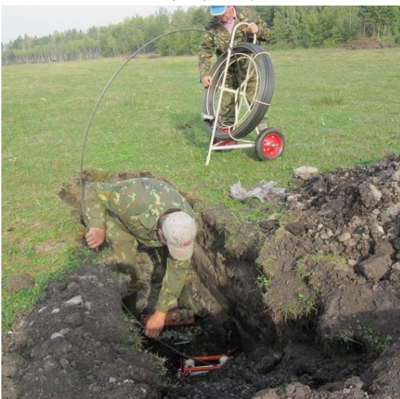
Рисунок 4 – Оценка внутреннего состояния коллектора из шурфа с применением устройства ОД-100 и муфты промывочной МПГ-1
