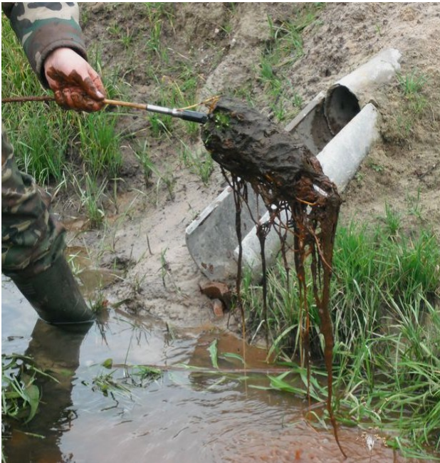
Рисунок 2 – Извлечение корней растений из устьевой части коллектора с применением насадки НК-1
