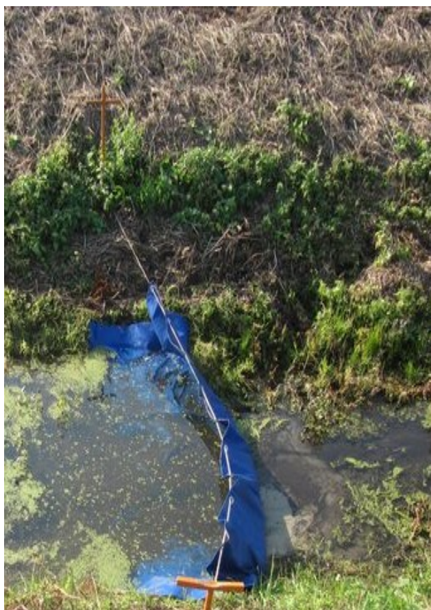
Рисунок 6 – Установка мягкой плотины МП-2 в русле канала
