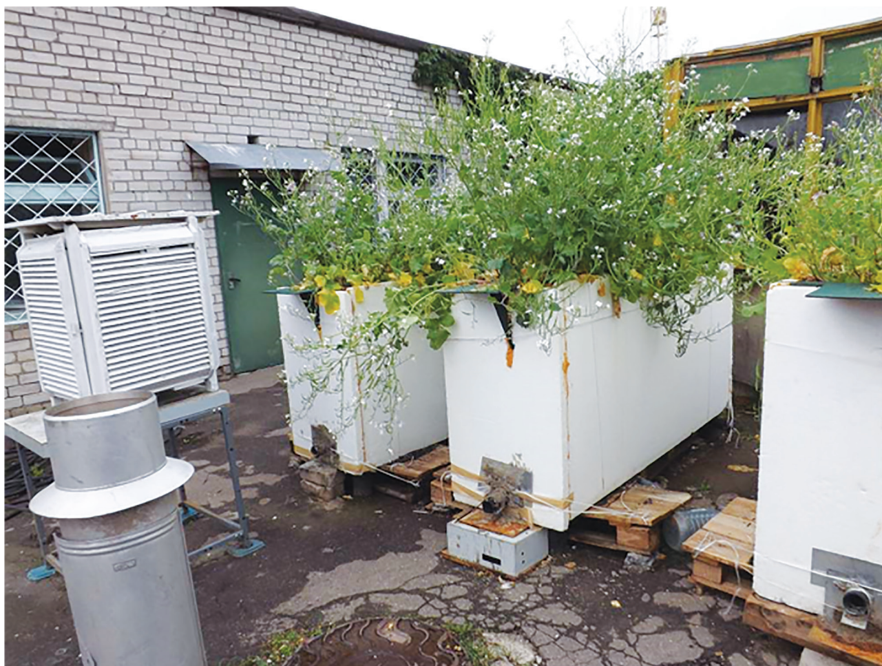
Рисунок 1 – Общий вид грунтовых лотков с рассматриваемыми вариантами конструкций дренажных линий
