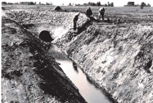
Рисунок 2 – Объект «Переброды» Витебской области, подготовка откоса у трубы-переезда к укреплению
