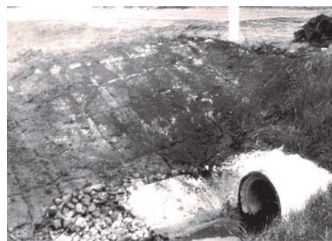
Рисунок 3 - Объект «Махновичи-5» Мозырского района, укрепленная биополотном труба-переезд
