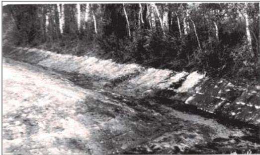
Рисунок 6 – Вид откоса канала, укрепленно-го биополотном с последующей присыпкой его почвогрунтом на мелиоративном объекте «Махновичи-5» Мозырского района Гомельской области
