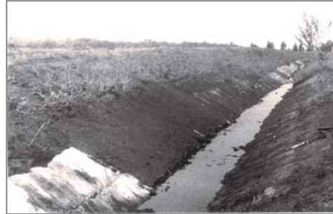
Рисунок 7 – Вид откоса канала, укрепленно-го биополотном с последующей присыпкой его почвогрунтом на мелиоративном объекте ПОМС Брестской области
