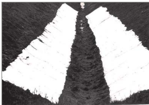
Рисунок 4 – Закрепление биополотна с шагом защемляемых почвогрунтом петель равным 700 мм
