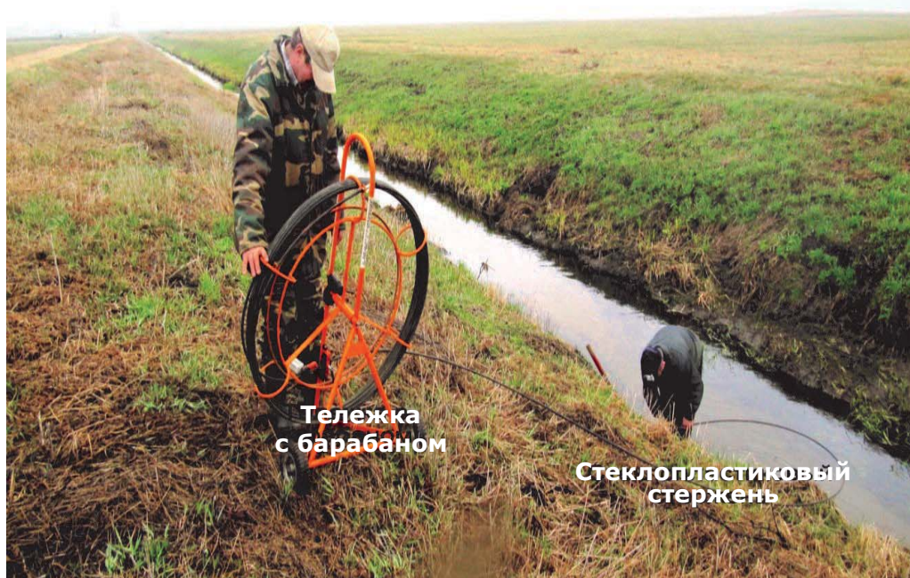
Рисунок 1 – Оценка внутреннего состояния коллектора с применением устройства ОД-100
