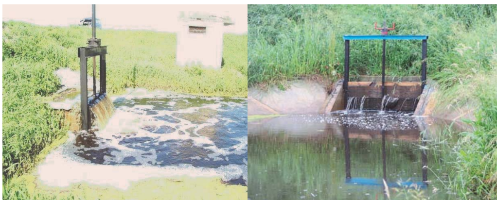
Рисунок 2 – Внешний вид впускного сооружения до и после реконструкции
