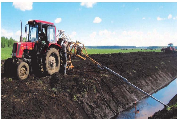
**Рисунок 4 – Промывка дренажных коллекторов установкой УПД-120 с применением направляющего устройства УНТ-6 конструкции РУП «Институт мелиорации».**
