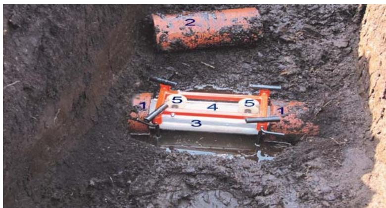
**Рисунок 2 – Установка муфты промывочной МПГ-1:**
