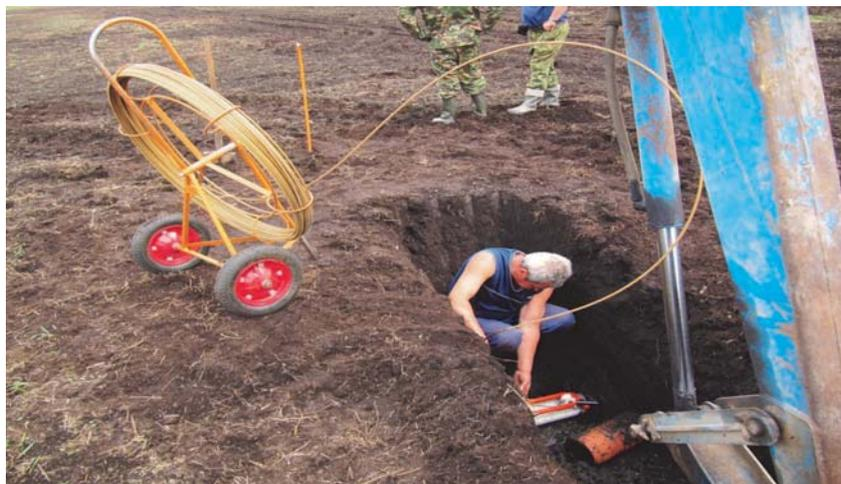
**Рисунок 3 – Оценка состояния внутренней полости дренажного коллектора с помощью устройства ОД-100 и промывочной муфты МПГ-1**
