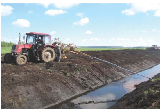
Рисунок 6 — Промывка коллекторной сети с применением направляющего устройства УНТ-6, устройства для забора воды ЗУ-2 и головки промывочной ГП-6
