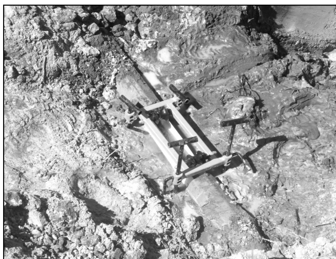
Рисунок 4 – Установка муфты промывочной МПГ-1 на трассе коллектора
