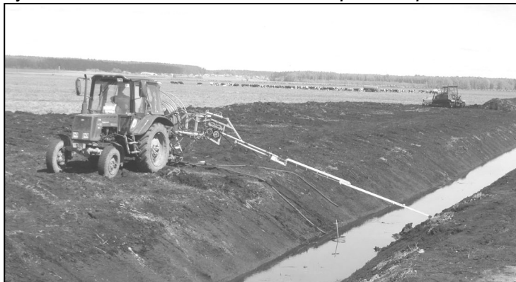
Рисунок 2 – Промывка дренажных коллекторов установкой УПД-120 с применением направляющего устройства УНТ-6 и устройства для забора воды ЗУ-2.
