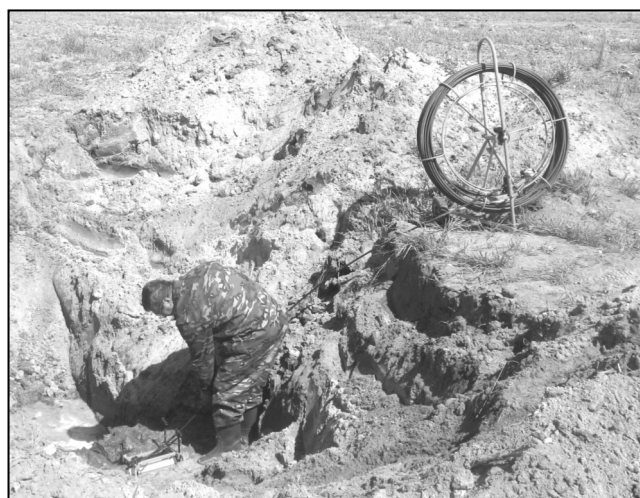
Рисунок 3 – Оценка внутреннего состояния коллектора устройством ОД-100 из шурфа с применением муфты промывочной МПГ-1
