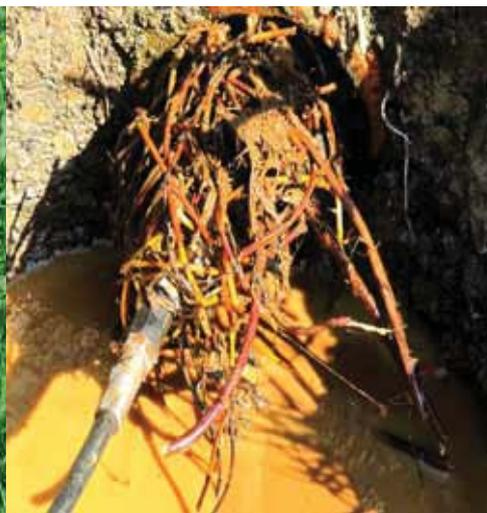
**Рис. 3 – Извлечение корней растений головкой винтовой ГВ-1.**
