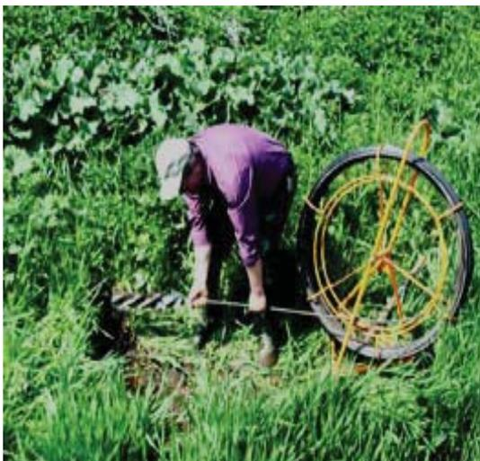
**Рис. 2 – Головка винтовая ГВ-1 на устройстве ОД-100 перед подачей в коллектор**
