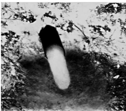
Рис. 3. Ледяная пробка в устьевой трубе дренажного устья (ОПУ «Шарковщинский»)
