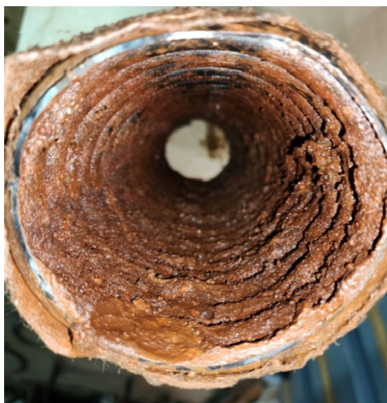
Труба 113 – до промывки
