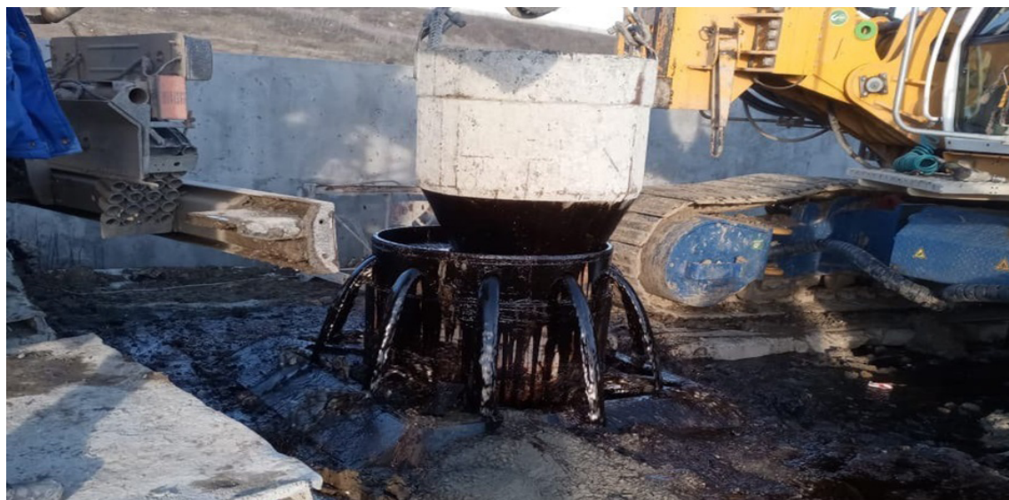
Рис. 2. Разлив нефти при бурении геологической скважины ПК36+54,68 М-25
