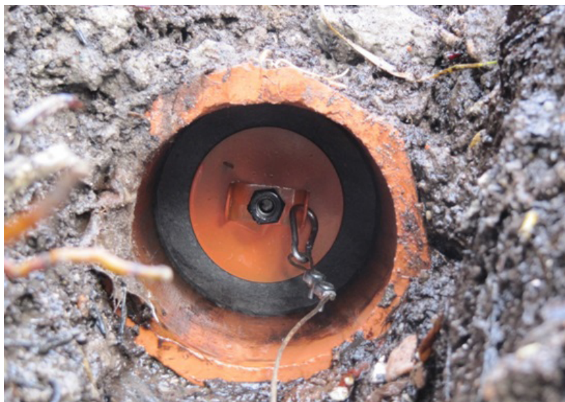
Рис. 6. Герметизатор в полости коллектора
