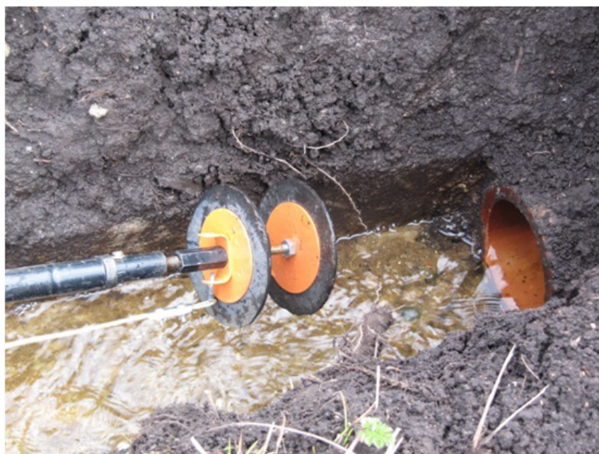
Рис. 5. Герметизатор на установочной штанге
