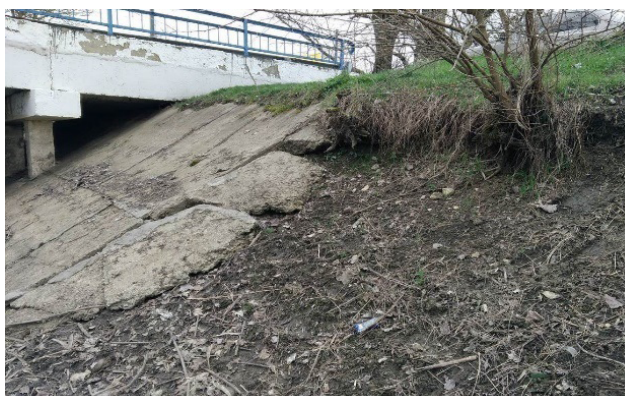
Рис. 2. Правобережный откос канала ниже моста. Разрушение плит крепления откоса
