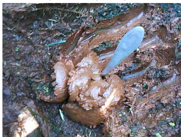
Рис. 5. Типичные песчано-охристые отложения в устьевом лотке крупным планом
