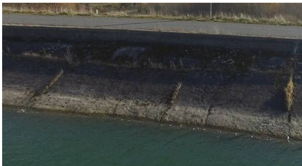
Рис. 13. Укрепленный откос плотины на Дубровском водохранилище
