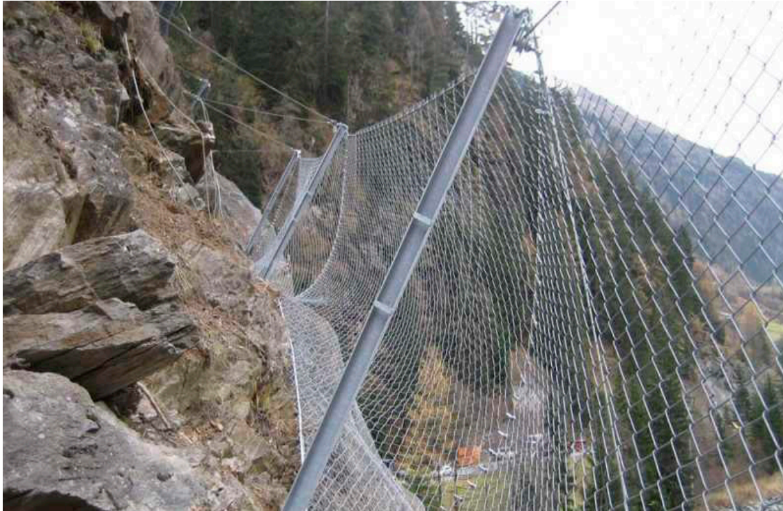
Рис. 5. Смонтированные гибкие улавливающие противообвальные сооружения в гп. Красная Поляна
