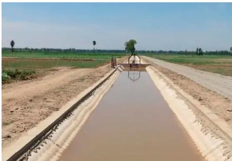
Рис. 3. Бетонная облицовка с применением формовочного мешка
