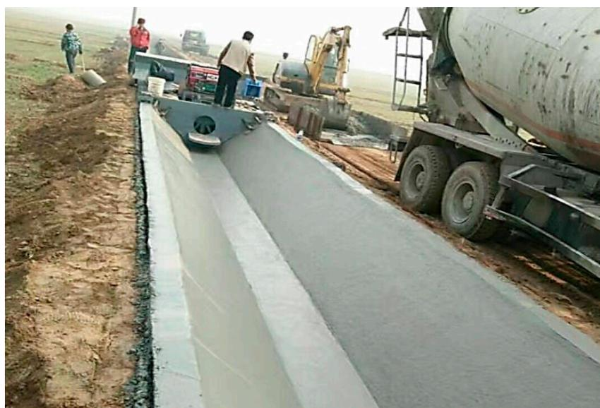
Рис. 2. Бетонная облицовка поперечного сечения канала
