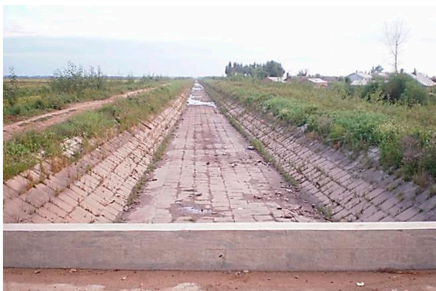
Рис. 1. Облицовка канала сборными железобетонными плитами
