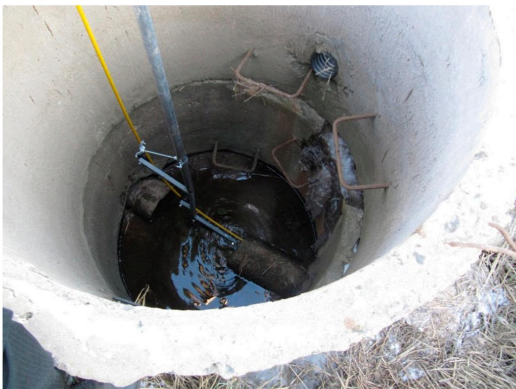
Рис. 4. Штанга направляющая ШН-4 во время очистки коллектора из колодца
