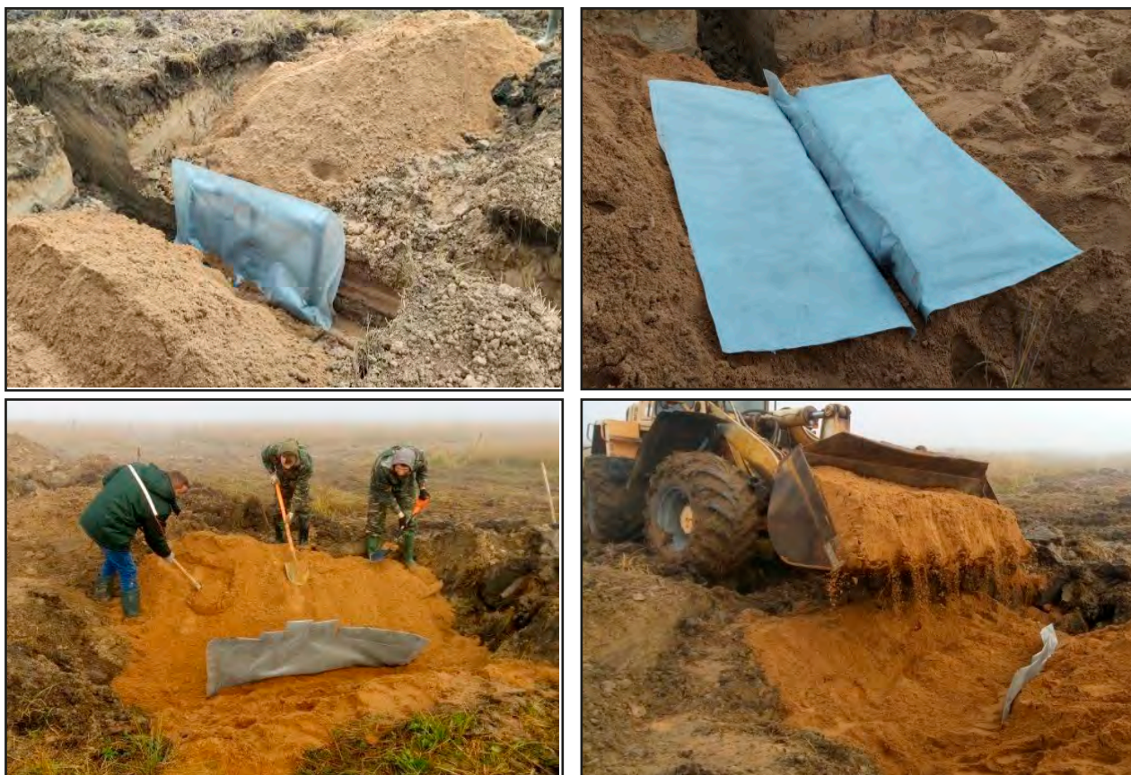
Рис. 7. Этапы технологии строительства экспериментальных колонок-поглотителей с дренажными геокompозитами на опытно-производственном участке
