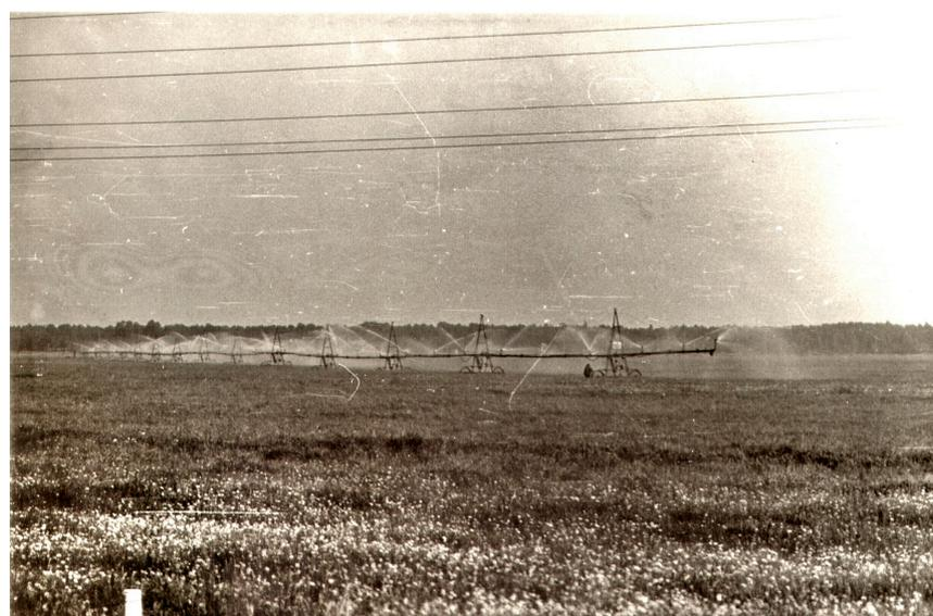
Рис. 2. Оросительная установка «Фрегат» в действии
