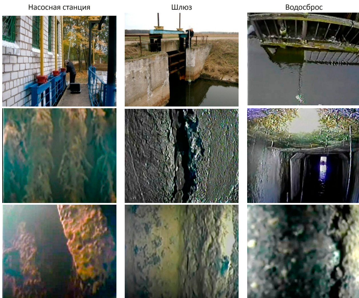
Рис. 5. Обследование труднодоступных участков ГТС при помощи устройства КСД-160У
