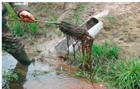
Извлечение корней растений из устьевой части Коллектора с применением насадки НК-1
