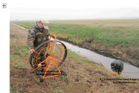
Обследование коллектора из устья
