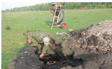
Обследование коллектора из шурфа
